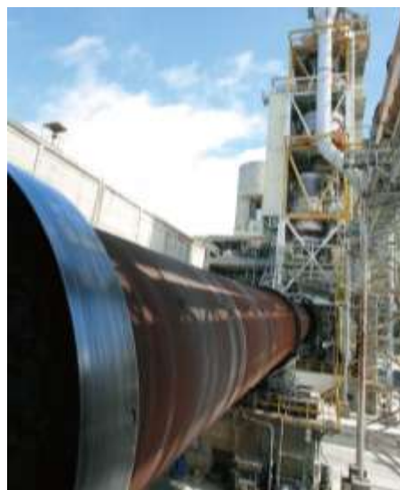
琉球セメント(株)屋部工場 セメント焼成用回転窯
